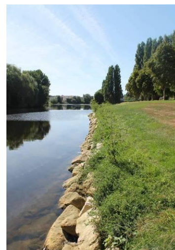
Photos des travaux de restauration de la berge des Ilettes par enrochements en amont du site : photos avant travaux (à gauche), à la fin des travaux (au milieu) et quatre mois après travaux (à droite)
