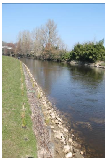
Photos des travaux de restauration de la berge des Ilettes en fascines de saules et plantation d'hélophytes sur le reste du site : photos avant travaux (à gauche), après la plantation des hélophytes (au milieu) et quatre mois après travaux (à droite)
