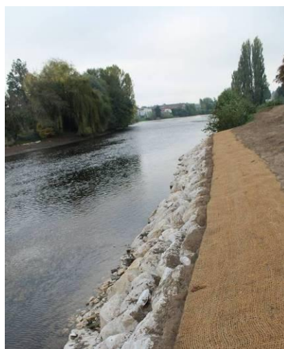
Photos des travaux de restauration de la berge des Ilettes par enrochements en amont du site : photos avant travaux (à gauche), à la fin des travaux (au milieu) et quatre mois après travaux (à droite)
