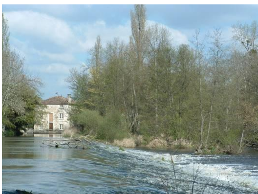
Seuil de Busserais
