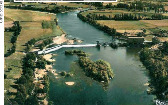
Le barrage de Maisons-Rouges avant travaux.
