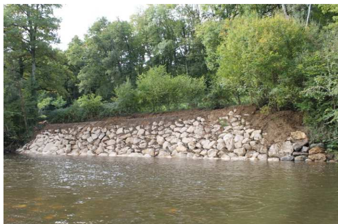
Le Pradeau après travaux
