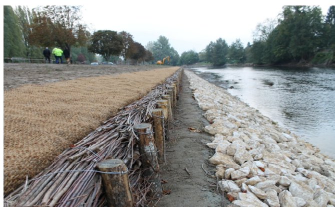
Les Ilettes après travaux
