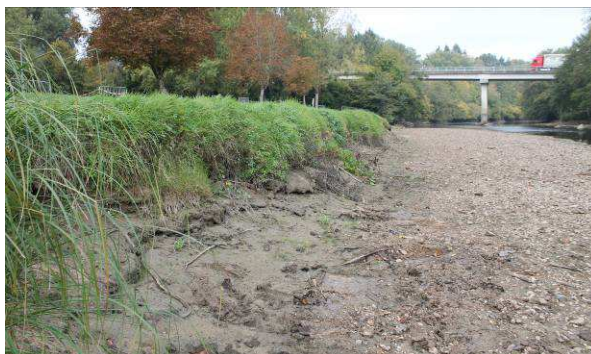
Erosion de la berge sur la partie aval de l'aire des Ilettes à Montmorillon
