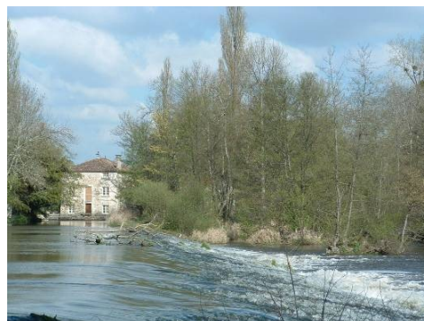
Ouvrage de Busserais
