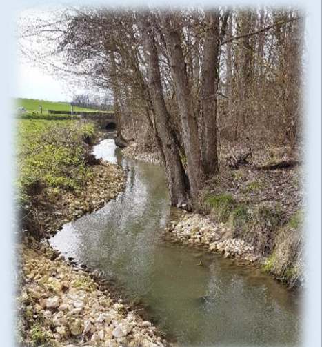
Travaux effectués sur le Ris en 2017
