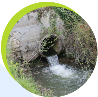
Le Ris - avant travaux
