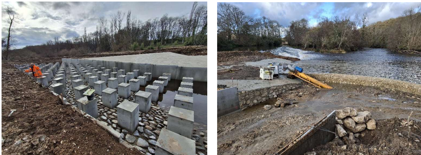
Passé à macrorugosité (à gauche) – Pré-barrages en construction (à droite))
