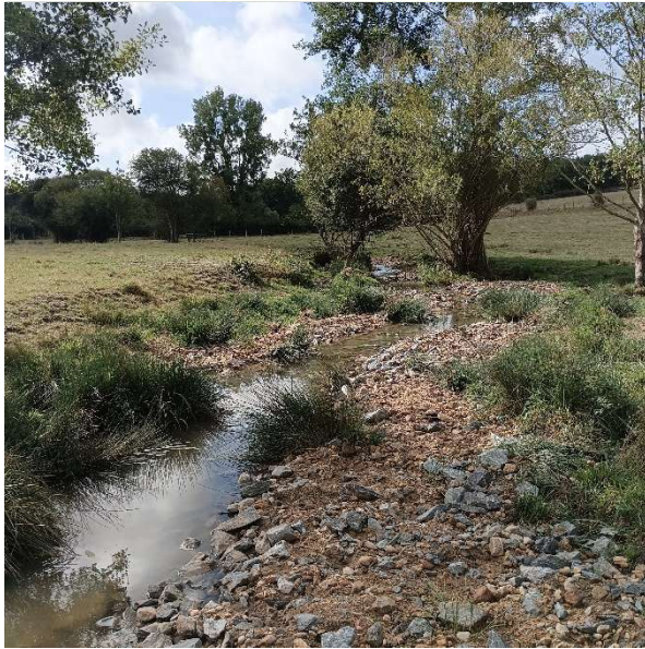
Reprofilage de berge et recharge granulométrique réalisés sur la Loire afin de resserrer la section d'écoulement, restaurer l'armure sédimentaire et recréer des habitats aquatiques
