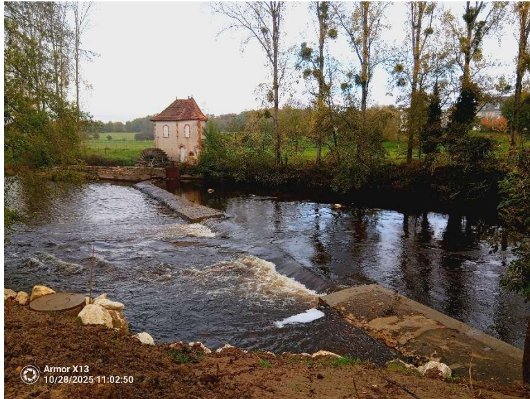
Ouvrage de Concise après travaux – Création d'une brèche calibrée
