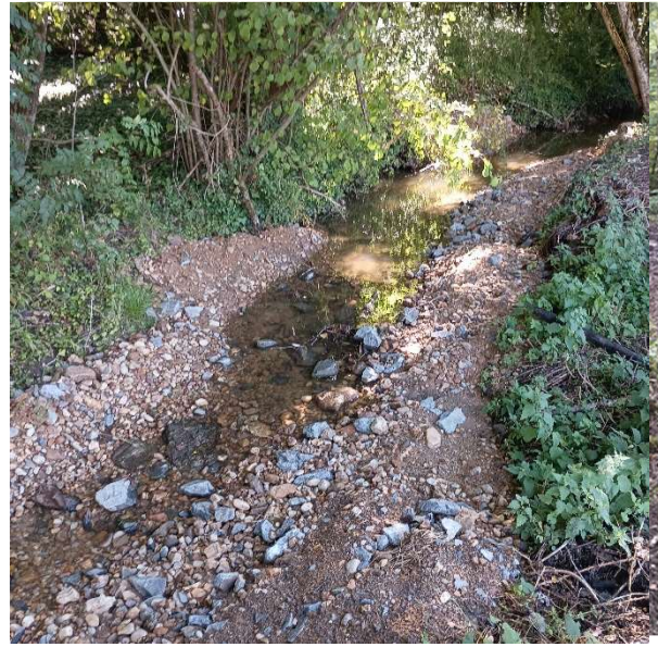
Reprofilage de berge et recharge granulométrique réalisés sur la Loire afin de resserrer la section d'écoulement, restaurer l'armure sédimentaire et recréer des habitats aquatiques
